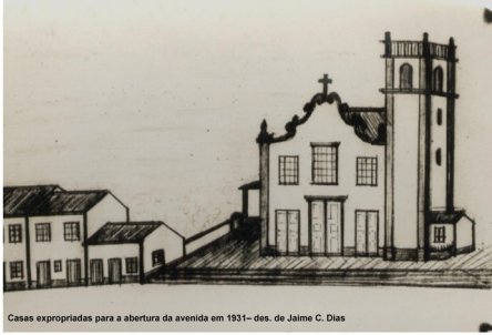
Casas expropriadas para a abertura da avenida em 1931 - des. de Jaime C. Dias
